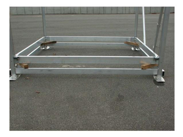
AS YOU ASSEMBLE THE BED BEAMS CHECK THE PULLYS FOR PROPER WINDING!!!
